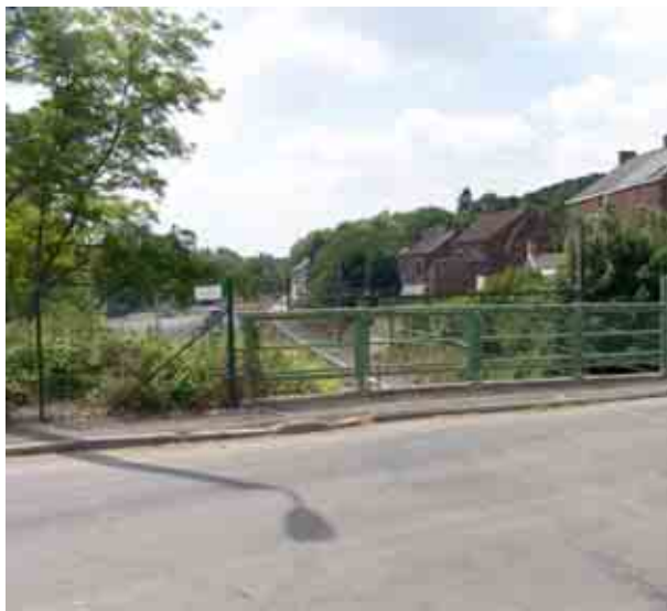
Rue de Leernes, pont sur le chemin de fer
