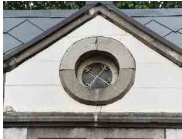
Petit pignon surmontant l'entrée percé d'un oculus en pierre
