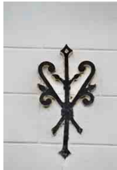
Détail d'une ancre métallique
