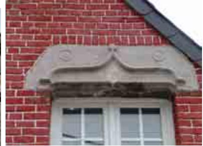
Linteau en accolade portant le millésime 1562 (ferme Stimant , place Sottiaux)
