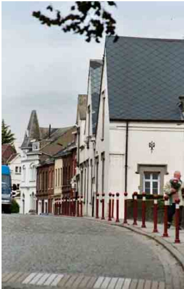
Enfilade bâtie de la rue de Marchienne : intéressant pavage préservé au cœur de la commune
