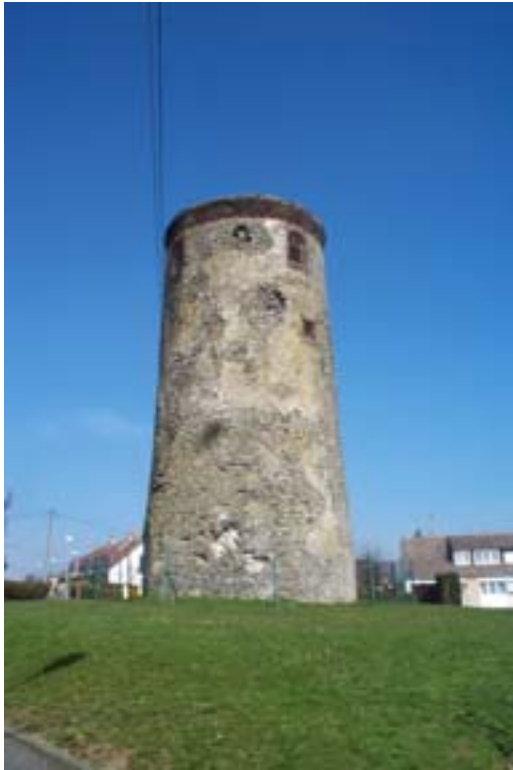
Le moulin de la parapette
