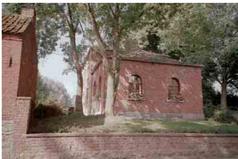
16. Ancienne école du village rénovée et réaffectée en habitat.
