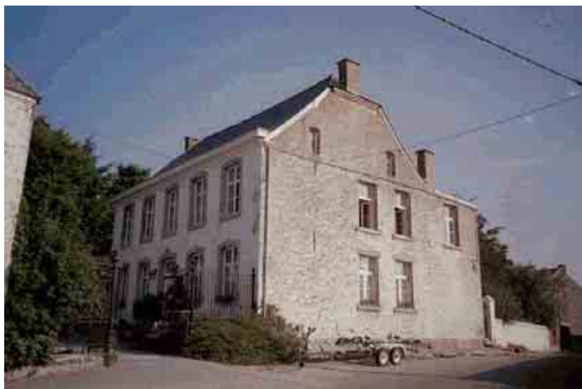
15. Rue du Tambourin, n° 4.
