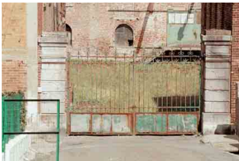
22. Grille d'entrée du moulin.
