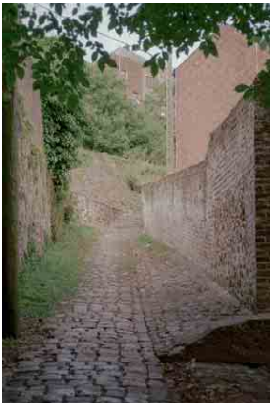
42. Ruelle dans le rempart du Midi.
