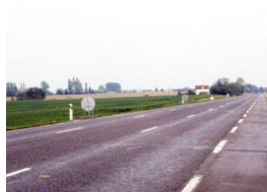
Vue depuis la RD 2 au nord de Maubeuge.
